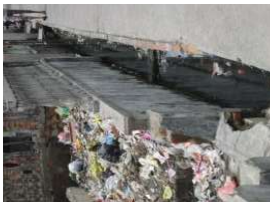
Gambar 1 Kondisi Drainase di Kelurahan Belawan II
