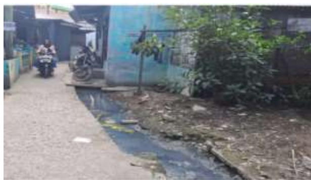
Gambar 2 Pendangkalan Drainase di Kelurahan Belawan II
